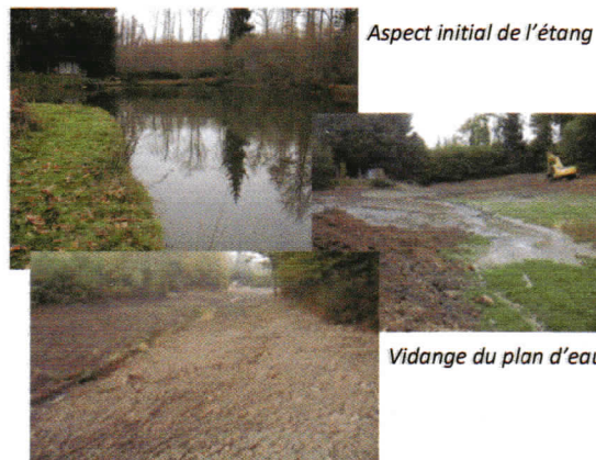
Mise en assec de l'étang avec reprise du cours d'eau
