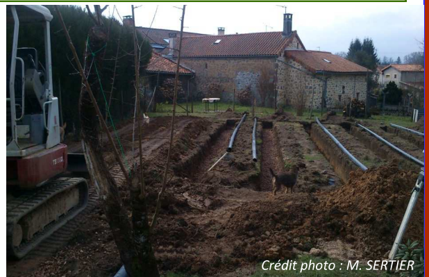
Photo pendant la réalisation des tranchées d'épandage
